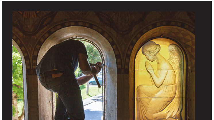
19 mai 2014, pose des verrières provisoires
